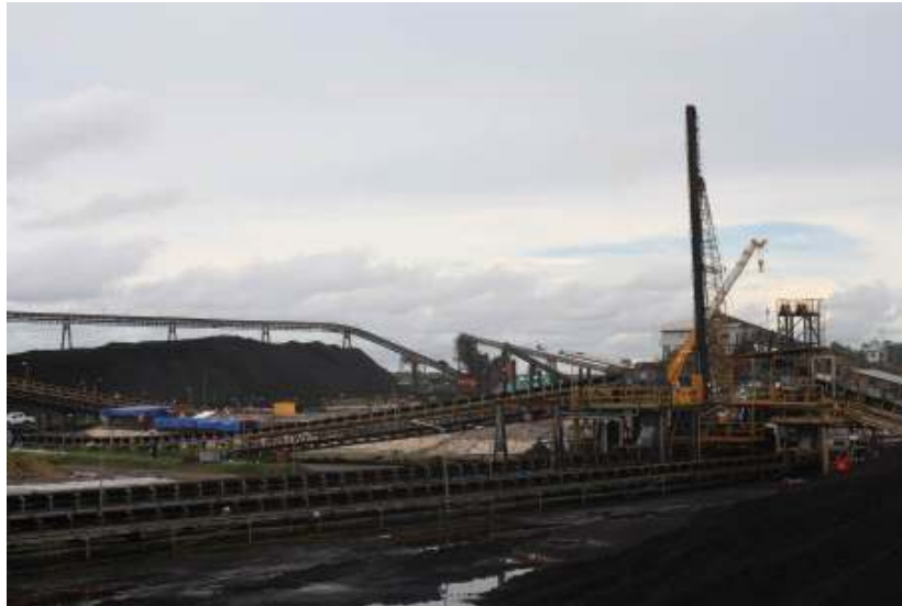
Proyek peningkatan Kelanis sedang dilaksanakan untuk meningkatkan kapasitasnya hingga mencapai sekitar 70 juta ton sampai akhir 2012
