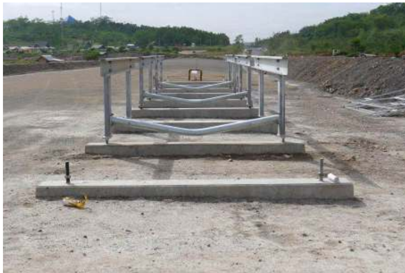
Pekerjaan engineering pada penempatan bingkai konveyor
