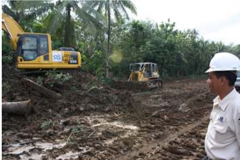
Pekerjaan pembukaan lahan jalan sepanjang 2,2 kilometer dari konsesi MIP
